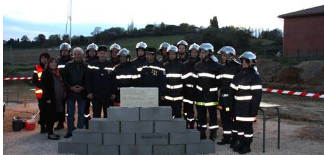
La 1ère pierre est posée !
